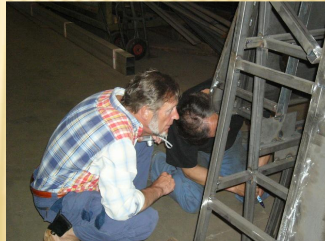
Het frame van het centrale gedeelte
