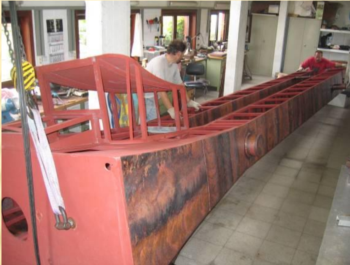
Het halfbeklede centrale gedeelte
